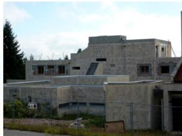
Le Clos des Visitandines Rehabilitación, Vaugneray (FR)
